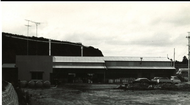
やきもの工場の全景(昭和47年ごろ) 左側に見えるのが500kgガスボンベ。大小のガス窯煙突
