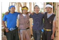
4人でタッグを組んで工房を建築中!
