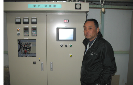
工場の責任者である柴邦太郎氏 日々工場内の管理運営に苦心されています。今回はトンネル窯の頭脳(計装盤)も最新のものにしました。
