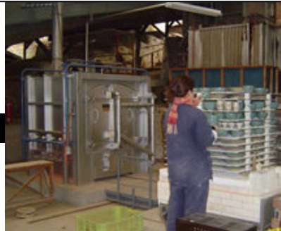
2004年7月完成の0.8㎡ガス窯 2.0㎡と同じトラパーサー式です。小口の注文にもスピーディに対応できるように2つの台車で交互に焼成できます。限られたスペースの中に窯本体、2台車とトランスカーを配置するという工事でした。設置場所を正確に測るところから始めました。
