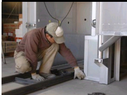
ガス窯の水平を出す作業 レンガ積み前にケーシングやレールを 納入時のために水平にします。
