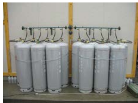
【プロパンガス 7本+7本立ての例】 窯の大きさによってボンベの本数は変わります。
