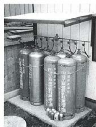
集合装置工事例
