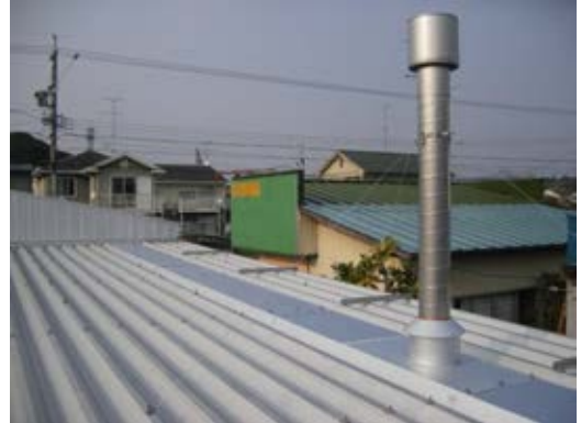
【スパイラル排気筒+折板屋根】
