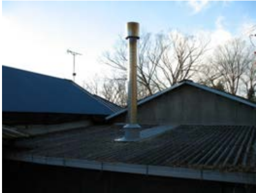
【スパイラル排気筒+スレート屋根（大波）】 （益子町・つかもと様 2.0 m 3 ガス窯）
